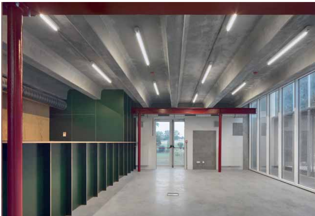
FOTO BOVEN TT-elementen in beton vormen de draagvloer van de polyvalente ruimte.
